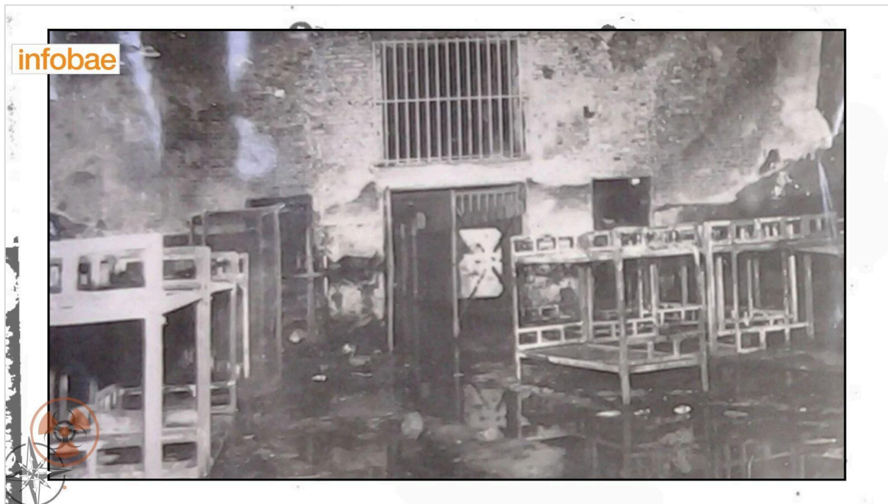
Image: Aftermath of the 1978 Cárcel de Devoto Fire
